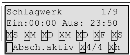
Abbildung 36: Nachtabschaltung der Schlagwerke
